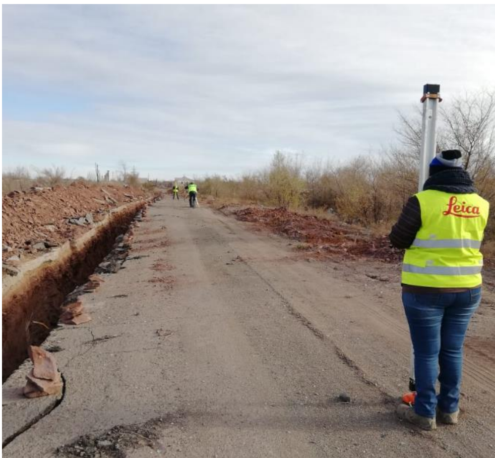
Рисунок 26 – Производство нивелирования, снятие отчета ЗП рейка
