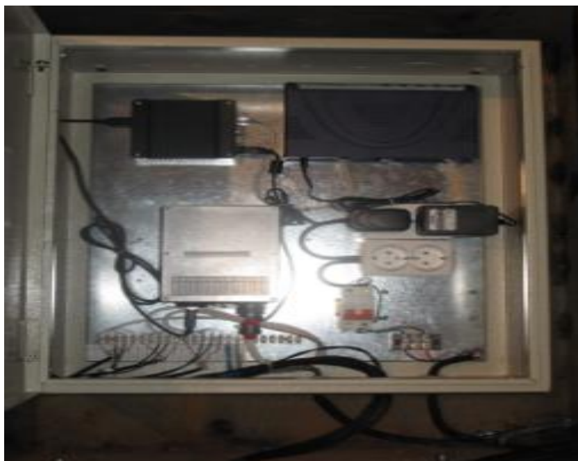
Рисунок 11 - Подземный полевой пункт СДСК-4М
